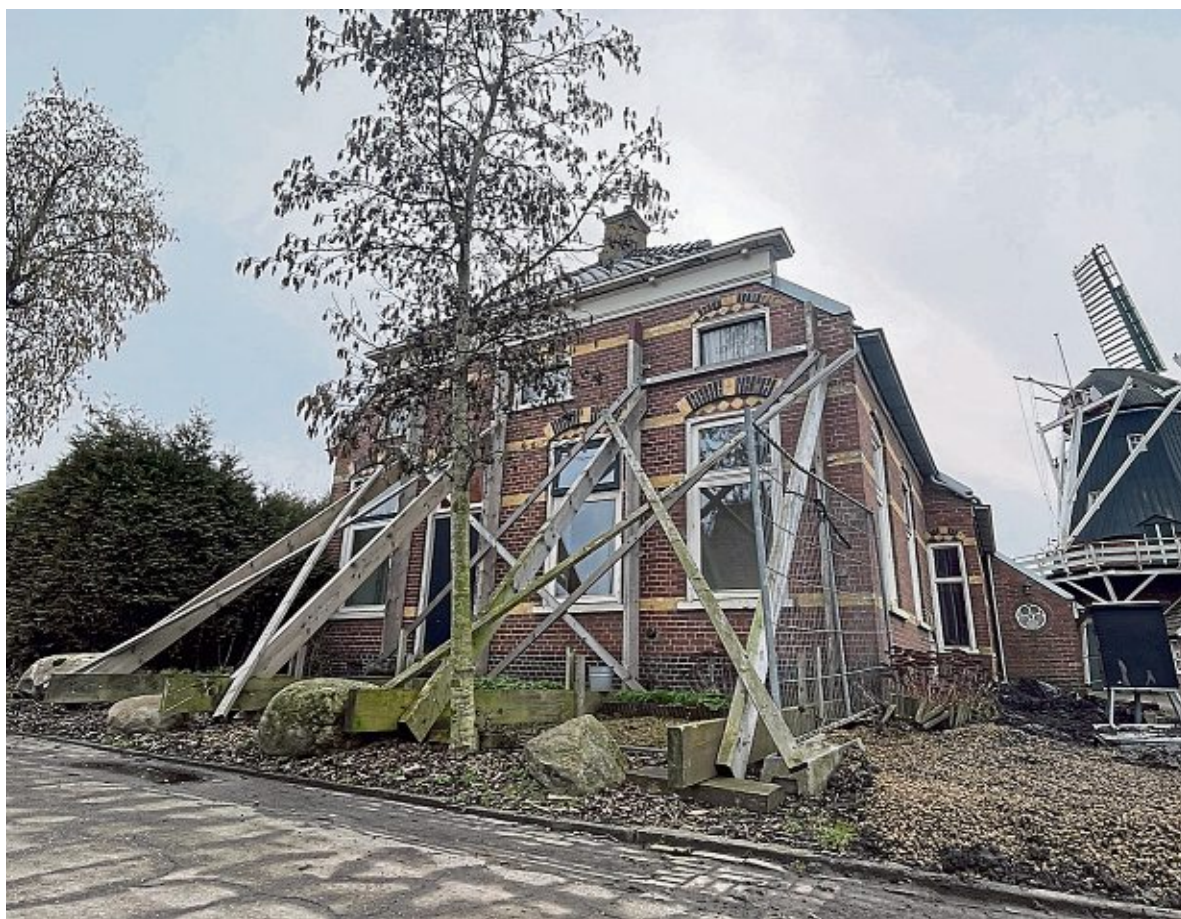
Ganze Häuser müssen in Groningen abgestützt werden, damit sie nicht einstürzen.
