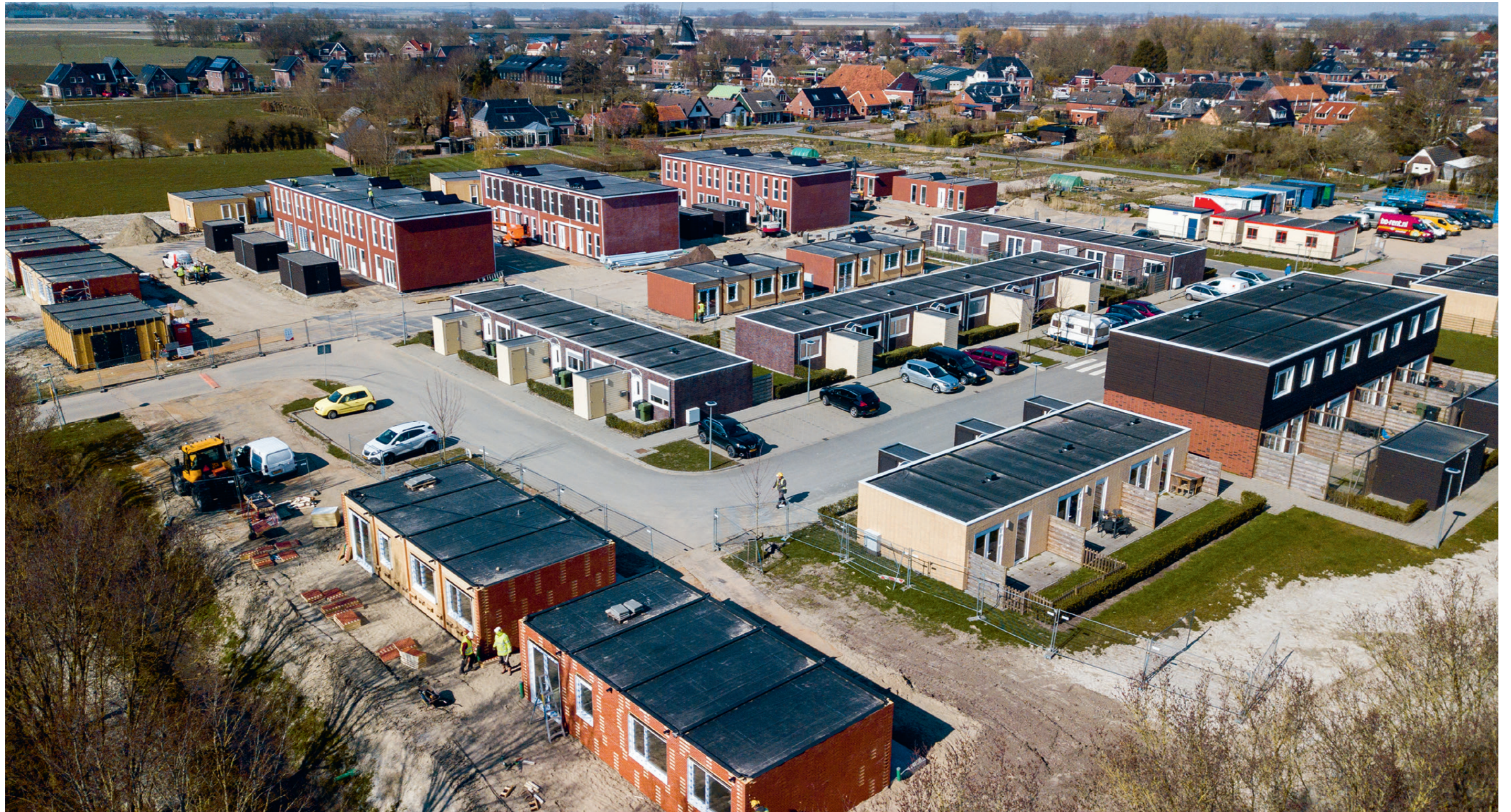
Versterkingsoperatie: Bouw wisselwoningen Loppersum
