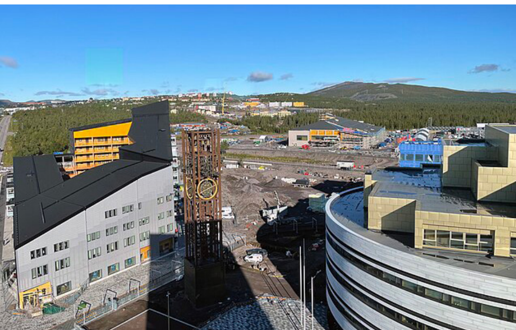
Afb. 37 Het nieuwe centrum van Kiruna in aanbouw.
